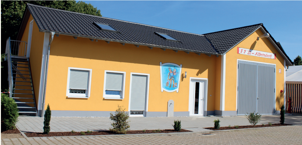
Das neue Gerätehaus der Freiwilligen Feuerwehr Alberndorf Foto: Gemeinde Wackersdorf
